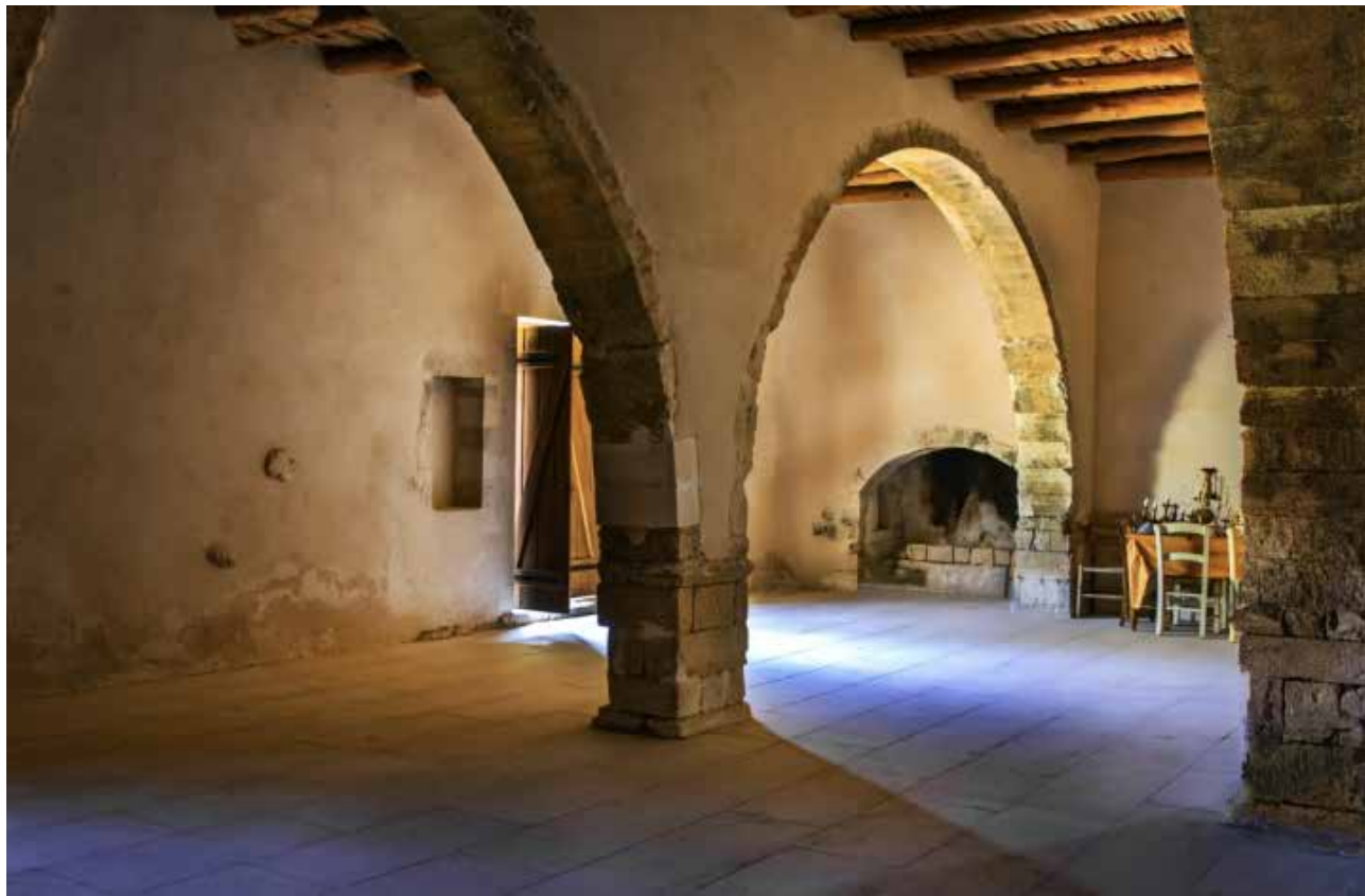
Frantoio, Creta, Regione di Chania, paese di Vamos. Comune di Apokoronas
