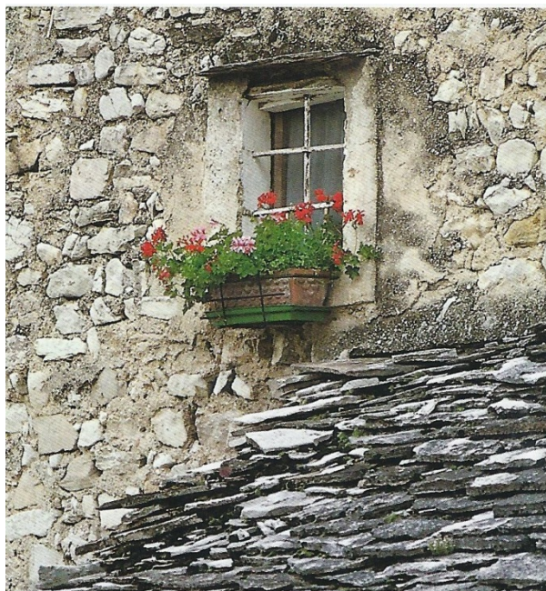
Finestrella con coperto a "laste" in una casa di Santa Maria (foto di © Giovanni Da Broi)
